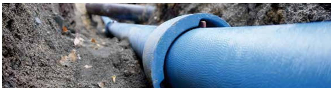
Cevovod sa VRS®-T/BLS® spojem kao protiv-požarni cevovod u tunelu
