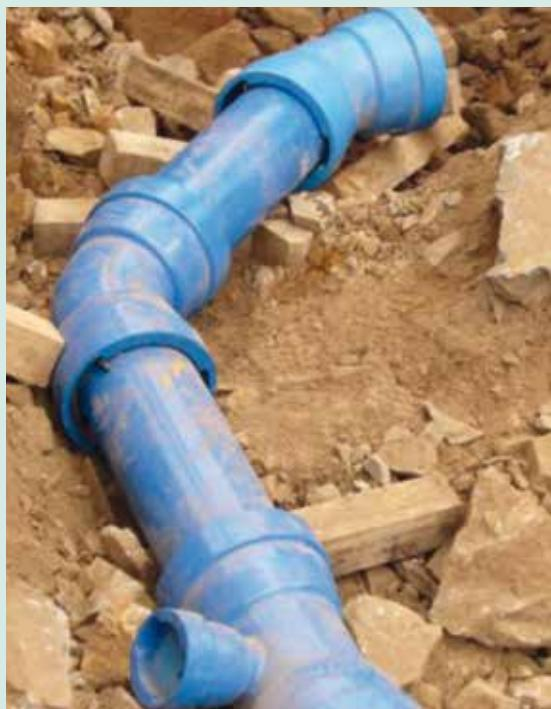
Moderna instalacija bez betonskih anker blokova
