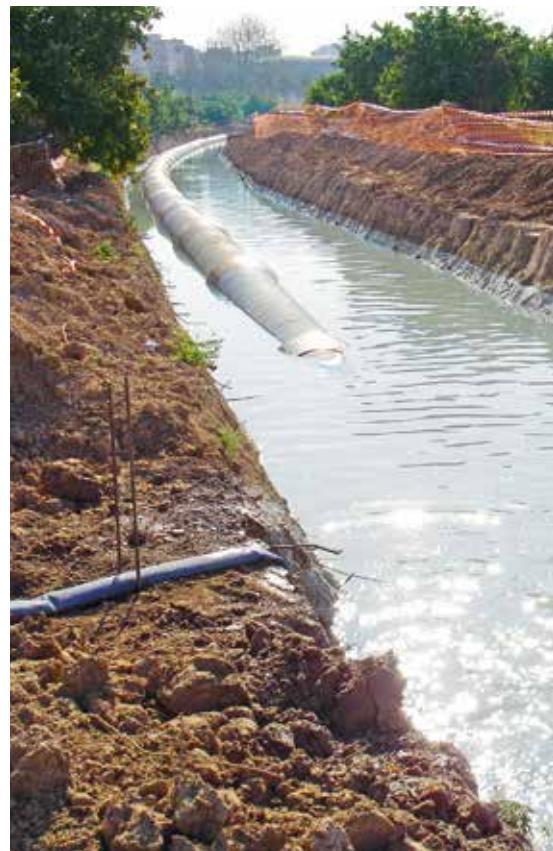
DN 900 usmereno izbušen cevovod kanala za odvod u Valensiji, Španija
