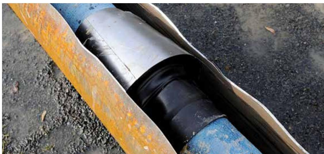
Čelični cevovod zamenjen duktilnim cevovod pomoću metode burstlining
