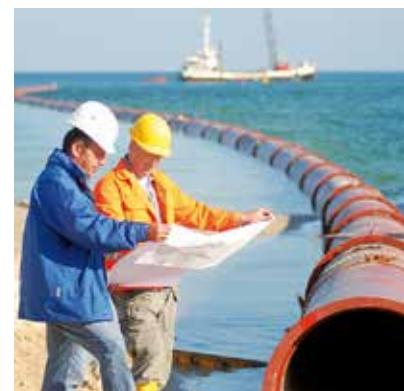
Primer plutajućeg cevovoda od duktilnog liva
