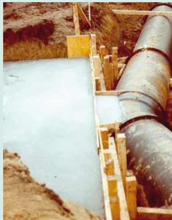
Konvencionalna instalacija sa betonskim anker blokovima
