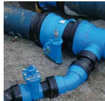
T komad, leptirasti ventil i zasun spojeni sa neraskidivim VRS®-T/BLS® spojem
