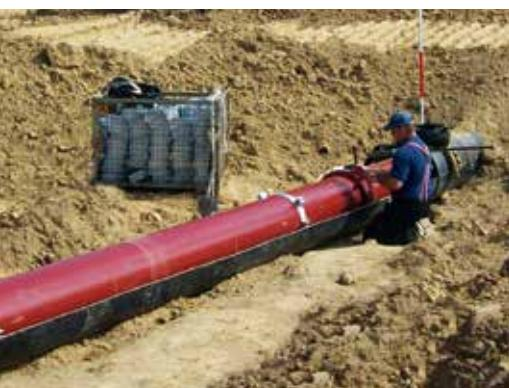
DN 400 duktilno-liveni cevovod sa VRS®-T/BLS® spojevima utisnut bez prekida u zaštitne cevi
