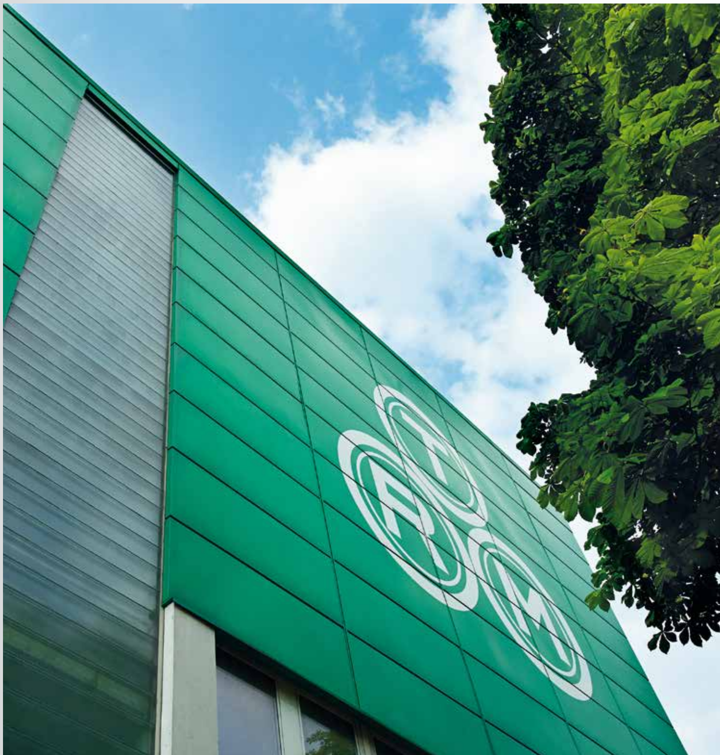
Proizvodni pogon Hall u Tirolu - baza za rešenja napravljena od gvožđa visokog kvaliteta.
